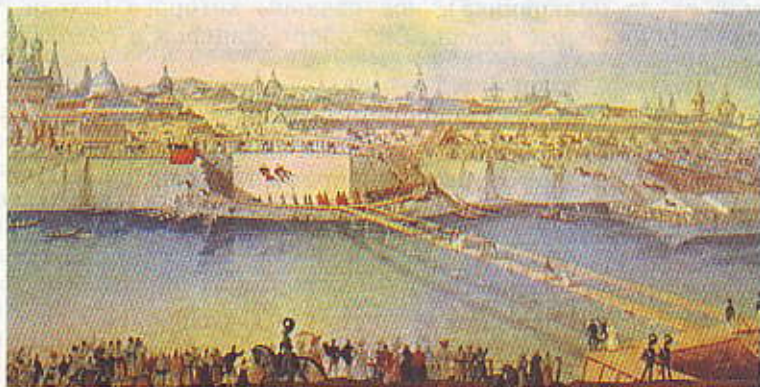
Закладка нового металлического моста в Москве в 1838 г.
